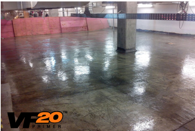
Floor coated with VF 20™ Primer
