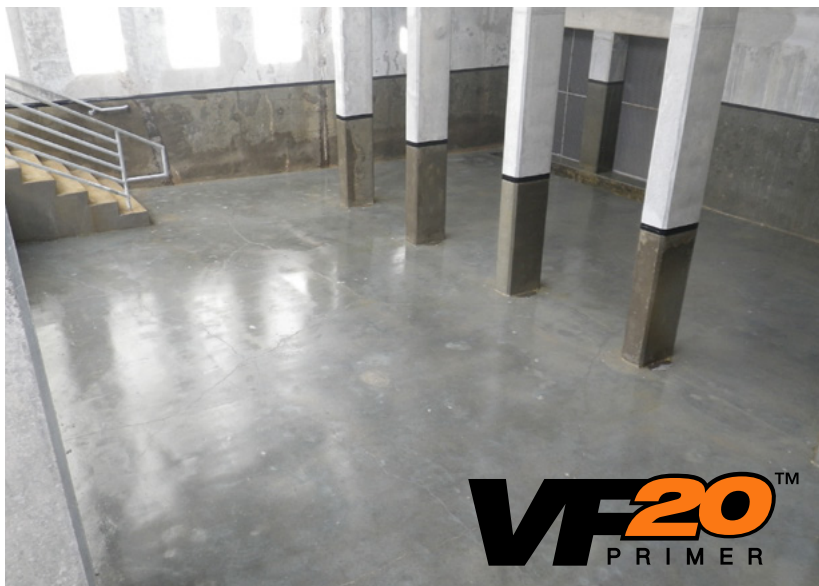
VF 20 Urethane Primer applied to concrete basin / columns
